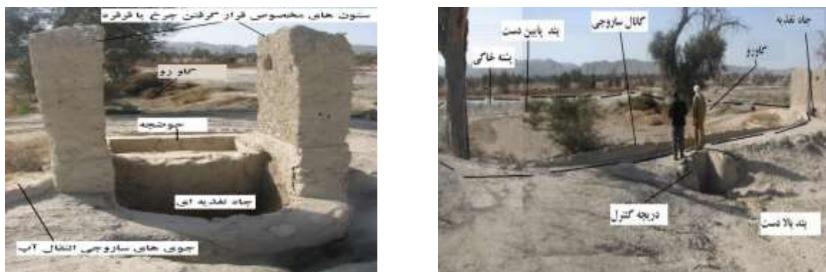
شکل (۴): اجزای سیستم چاه نزو
