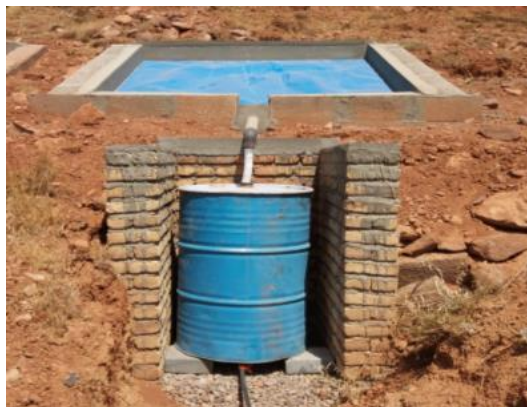
شکل (۳): نحوه اجرا و تکمیل سطح آبگیر پوشش ورق ژئوممبران
