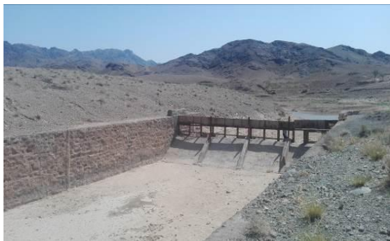
شکل ۶- دهانه آبیگر جانبی با زاویه ۹۰ درجه ساخته شده در رودخانه نای در آبخوان کاشمر Figure 6- A 90-degree lateral Intake Span built on the Nay River on the Kashmar aquifer
