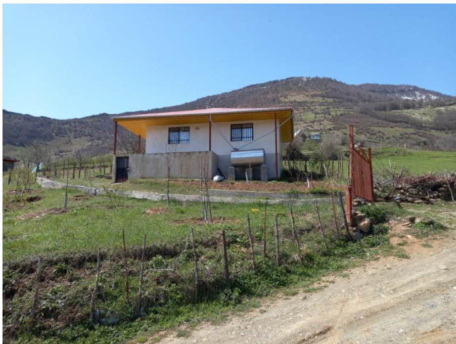
شکل ۱- نمایی از استحصال آب باران از سقف شیروانی در روستای سراورسو Figure 1- A view of rainwater harvesting from a gable roof in the village of Saraversoo
