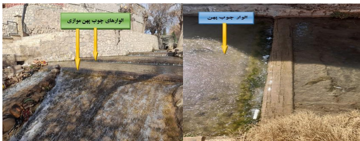
شکل ۴- الوار چوب پهن در مسیر نهرها
