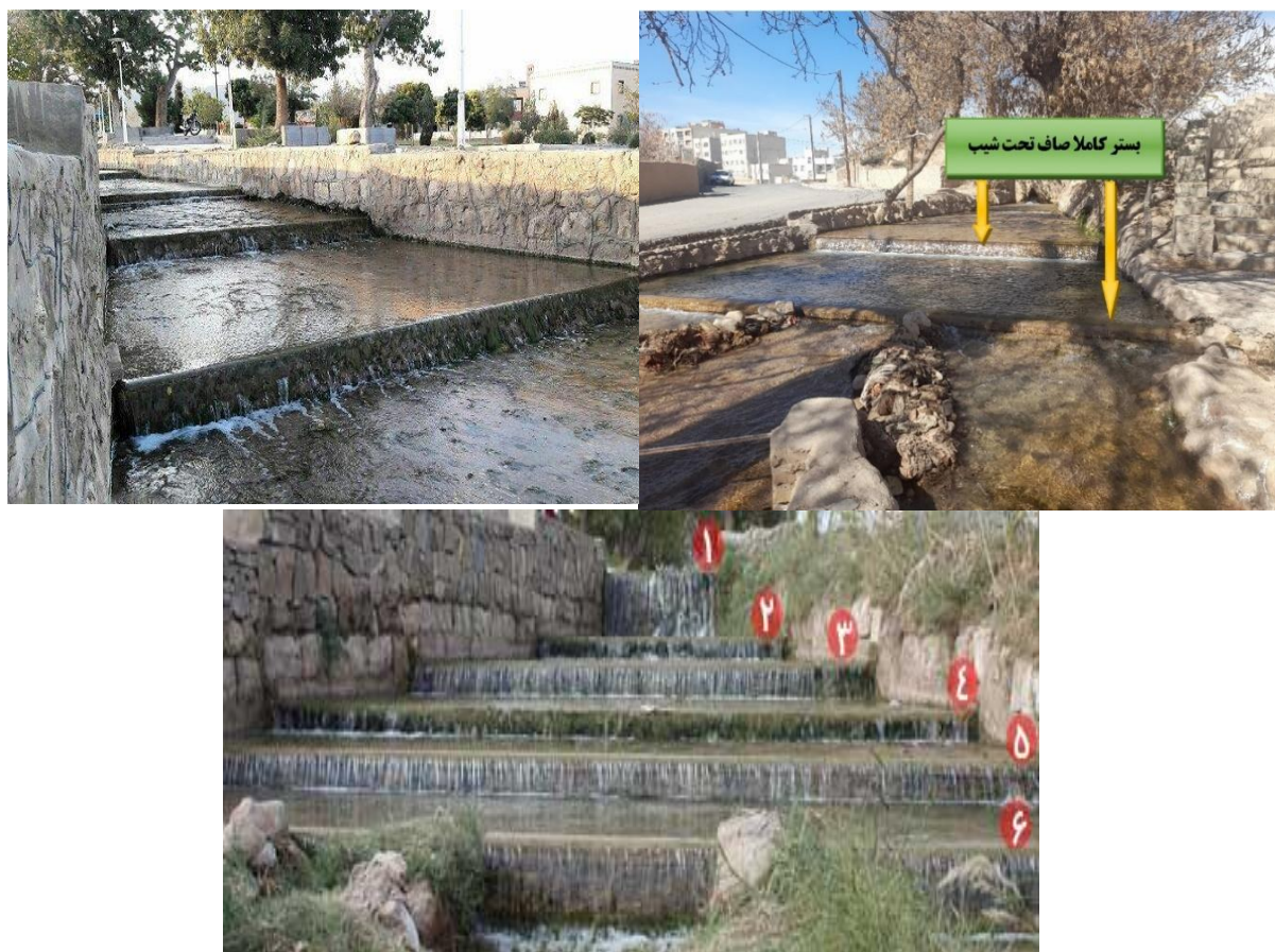
شکل ۲- آب‌پخش‌کن پارا Figure 2- Para Water Divider
