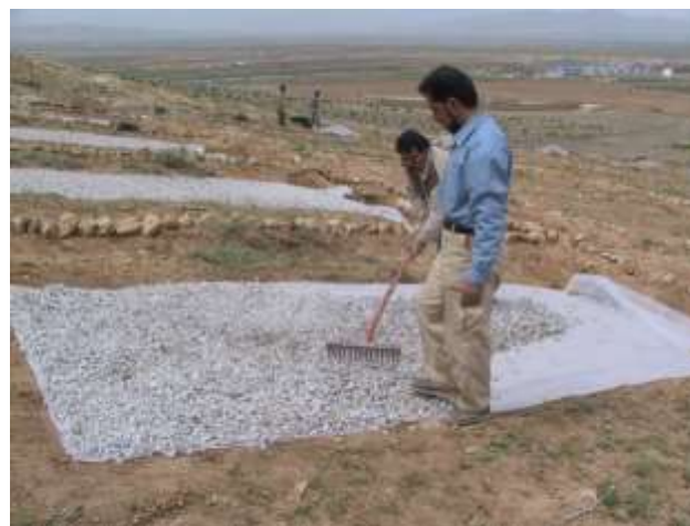
شکل (۳): عایق نمودن سطح سامانه آبگیر با استفاده از پلاستیک و سنگریزه
