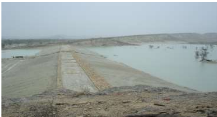
شکل (۳): نمونه ای از چشک‌های احداث شده در طرح‌های آبخیزداری جزیره قشم
