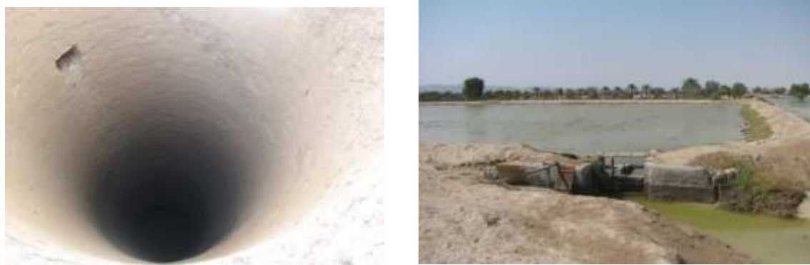
شکل (۵): نمایی از درون چاه نزو با دیواره سنگ و ساروج و دریچه ورود آب به داخل چاه (مدیریت رواناب و تغذیه آبخوان با تزریق مستقیم آب و حذف عبور آب از لایه‌های گچی و املاح نامناسب)
