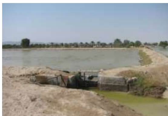
شکل (۵): نمایی از درون چاه نزو با دیواره سنگ و ساروج و دریچه ورود آب به داخل چاه (مدیریت رواناب و تغذیه آبخوان با تزریق مستقیم آب و حذف عبور آب از لایه‌های گچی و املاح نامناسب)
