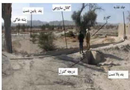
شکل (۴): اجزای سیستم چاه نزو
