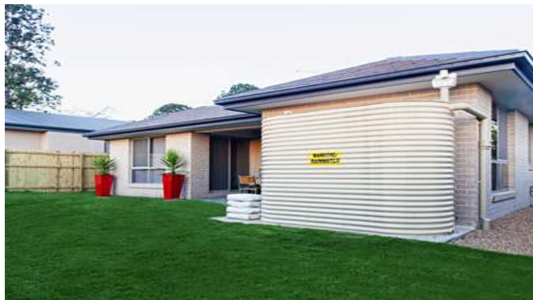
شکل (۲): نمونه‌ای از نصب مخازن جدید استحصال آب باران در خانه‌های استرالیایی
