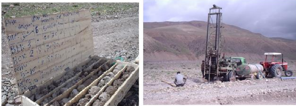
شکل (۷): حفاری چاه‌های ژئوتکنیکی در محور سد
