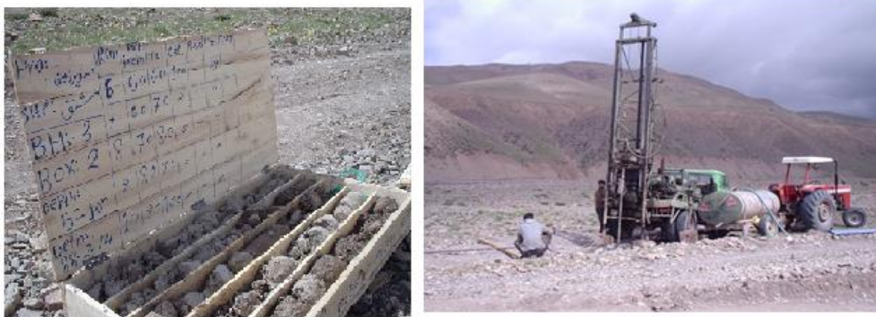
شکل (۷): حفاری چاه‌های ژئوتکنیکی در محور سد
