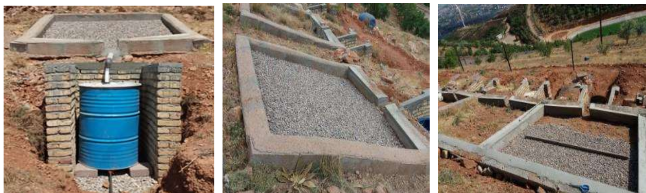
شکل (۳): نحوه اجرا و تکمیل شده سطح آبگیر طبیعی با مالچ شنی
