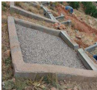
شکل (۳): نحوه اجرا و تکمیل شده سطح آبگیر طبیعی با مالچ شنی
