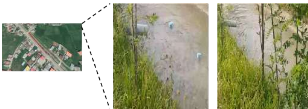
شکل (۱): مسیر حرکت شناورهای GPS در کانال روباز بتنی واقع در روستای آقا سید شریف
