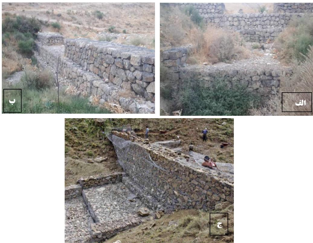
شکل (۲): سازه‌های مکانیکی سرربیز پلکانی و حوضچه پایین‌دست احداثی (الف)، تاج سرربیز توری‌سنگی و مقطع عرضی آبراهه (ب) و عملیات اجرایی سازه توری‌سنگی (ج)
