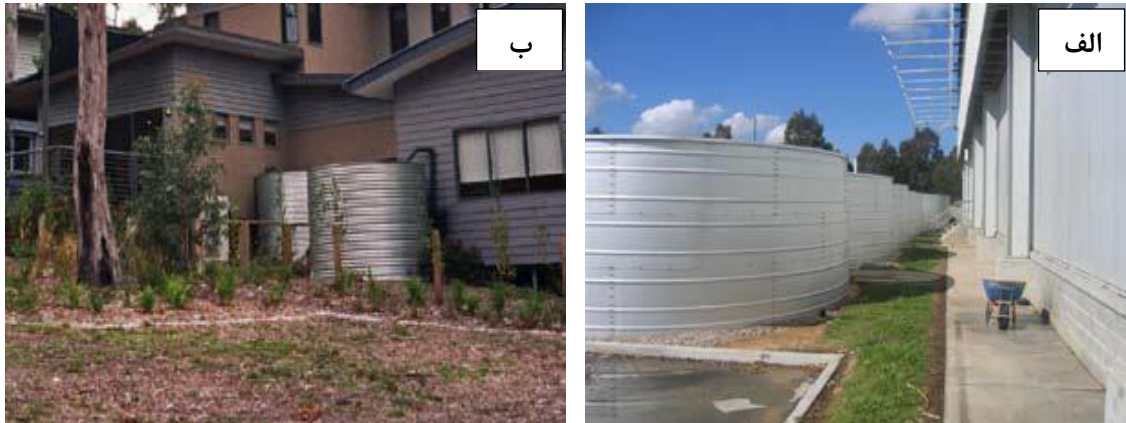
شکل (۷): استحصال آب از سطح پشت‌بام و ذخیره‌سازی آن در مناطق تجاری (الف) و مسکونی (ب) استرالیا
