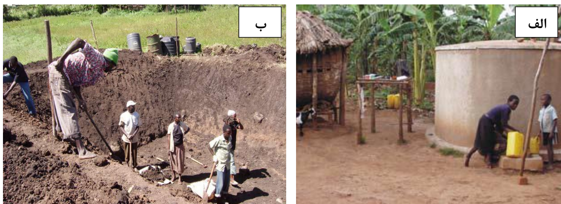
شکل (۶): استحصال آب از سطح پشت‌بام و ذخیره‌سازی در مخزن سیمانی (الف) و حفر مخزن جهت ذخیره‌سازی آب باران (ب)
