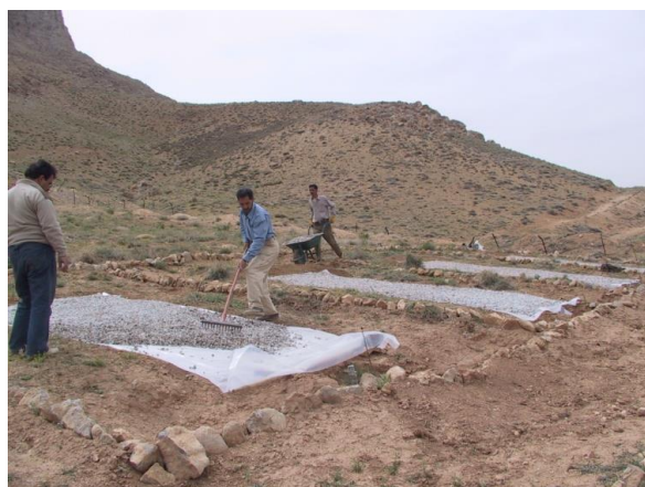
شکل ۵- عایق نمودن سطح سامانه آبگیر با استفاده از پلاستیک و سنگریزه Figure 5- Insulating the surface of microcatchment using plastic and gravel
