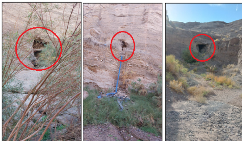
شکل ۴- موقعیت تعدادی از مسیرهای دسترسی به سفته جهت انجام عملیات لایروبی، تنظیف و نگهداری
