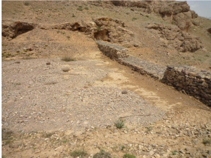
شکل (۴): مخزن یکی از بندهای گابیونی که از رسوب درشت دانه پر شده است.
