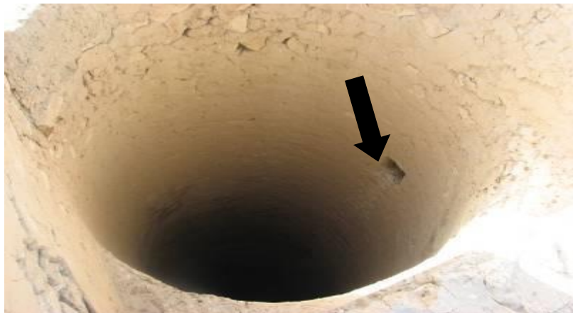
شکل (۵): نمایی از داخل چاه تغذیه‌ای و دریچه ورود آب به داخل چاه، دیواره از سنگ و ساروج
