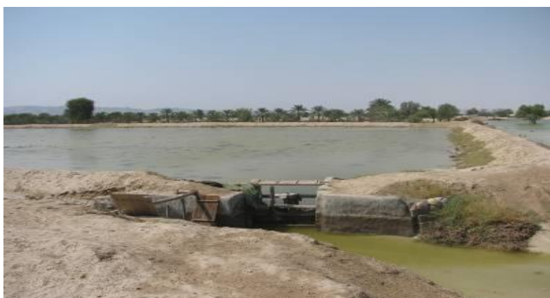
شکل (۱۲): جمع‌آوری آب در تیربندها و تغذیه از طریق چاه‌های نزو
