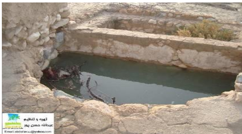
شکل (۱۱): نمونه‌ای از چاه تغذیه مصنوعی پس از بارندگی و تزریق آب (عکس از عبدالله حسن پور)
