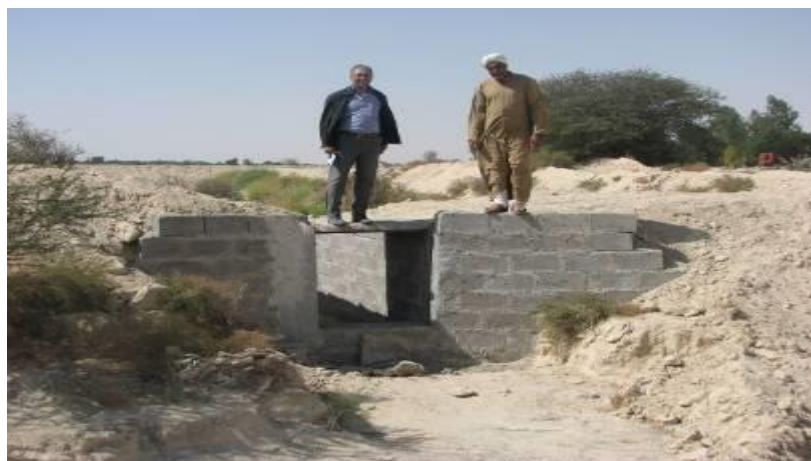
شکل (۱۶): نمایی از دهانه ورودی استخر تغذیه
