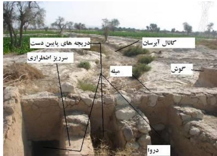
شکل (۳): نمایی از یک علگه و اجزای مختلف آن از پایین دست (چشک‌ها در قسمت بالا دست بوده و در پشت میله قرار دارد و در تصویر دیده نمی‌شوند)
