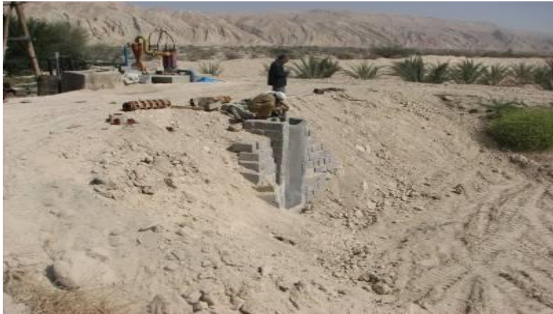
شکل (۱۷): نمایی از دریچه ورودی آب به چاه، همراه با لوله‌ها، توری محافظ، دیواره اطراف و چاه مجاور آن که در پایین‌ترین نقطه استخر تغذیه قرار دارد
