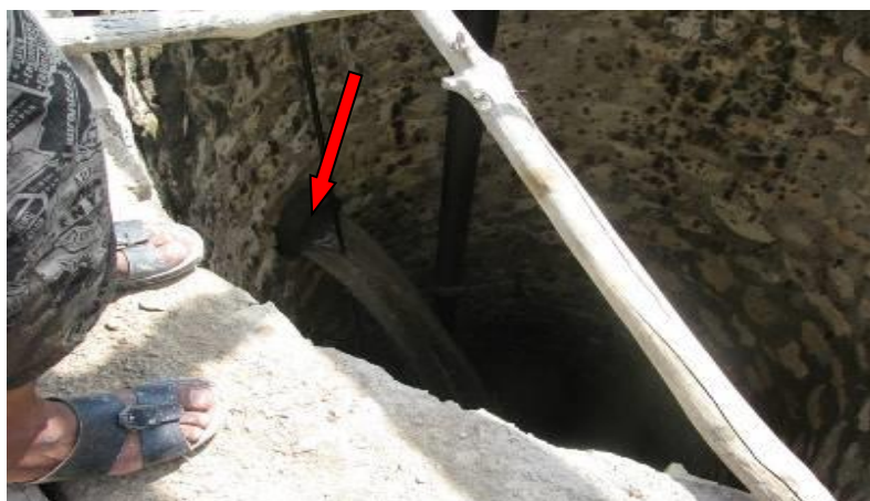
شکل (۱۰): نمایی از چاه نزو در حال تزریق مستقیم آب از طریق دریچه یا لوله (دشت گزیر)
