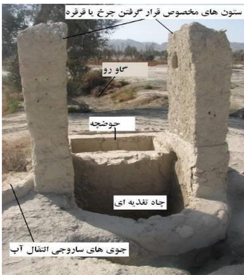
شکل (۸): قسمت‌های مختلف یک چاه چرخ گاوی که همان چاه تغذیه‌ای می‌باشد
