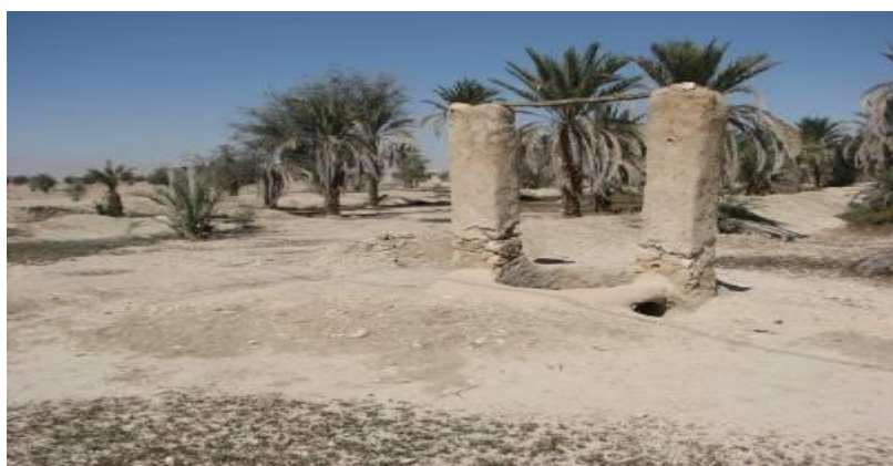
شکل (۱۳): چاه نزو که در درون بند در نقطه‌ای بالاتر نسبت به سطح عمومی بند واقع شده است
