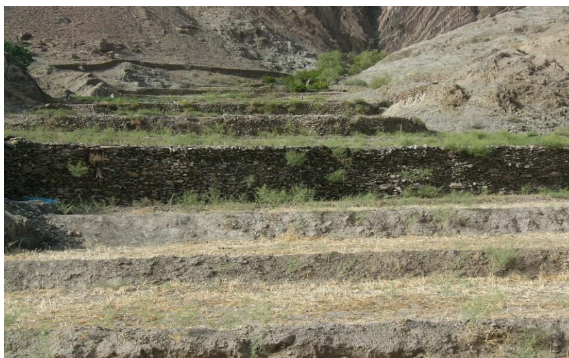
شکل (۲): نمایی از سنگ‌های به کار رفته در دیواره سازه‌های احداثی
