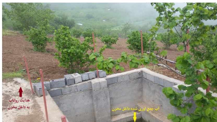
شکل (۱۳): نمایی از جمع‌آوری آب باران از سطح کوچک آبگیر، هدایت رواناب به داخل مخزن از طریق بازوهای کوتاه‌اندازه‌ای و ذخیره آب در حوضچه‌ها احداث شده به حجم تقریبی ۶۰ مترمکعب به منظور آبیاری تکمیلی درختان فندق (روستای سراورسو اشکورات رودسر)
