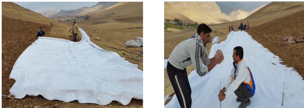
شکل (۵): آماده سازی و نصب پارچه مخصوص (ژئوتکستایل) در انتهای زمین
