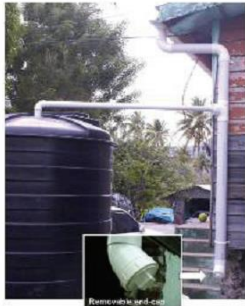
شکل (۴): سیستم جدا کننده فلاش اول بارش بر اساس مکانیزم توپ شناور (یکی از روش‌های پیشنهادی) منبع: کمیسیون کاربردی علوم زمین اقیانوس آرام جنوبی (SOPAC)
