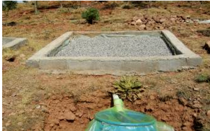
شکل (۵): تیمار سطح پلاستیک با پوشش شنی به همراه مخزن ذخیره رواناب
