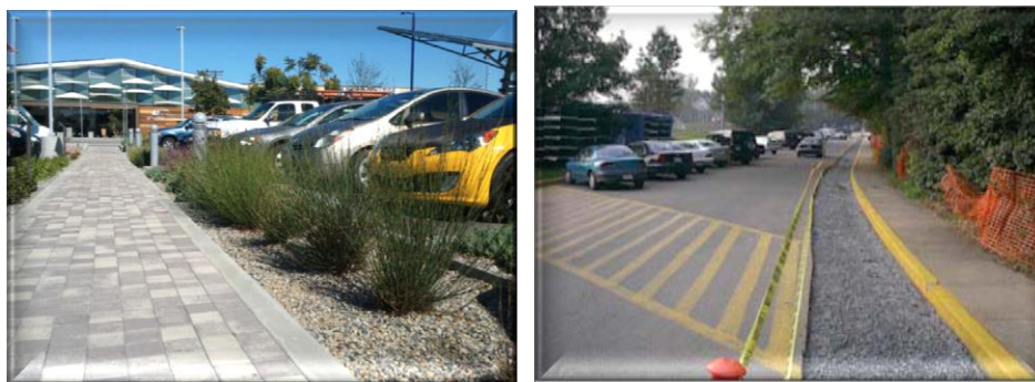
شکل (۵): ترانسه نفوذ در حاشیه جاده (سمت راست) و پارکینگ (سمت چپ)
