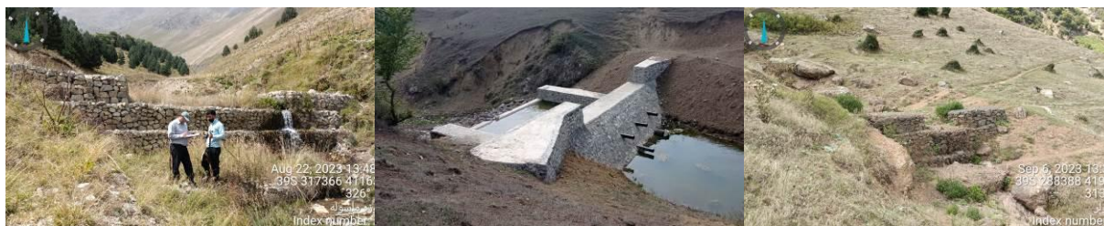
شکل ۳- نمایی از سازه‌های گابیونی و سنگی ملاتی حوزه‌های آق اولر (تصویر راست)، توتکابن (تصویر وسط) و ماسوله (تصویر چپ) Figure 3- Gabion and masonry wall in the Aghevlar (right image), Tutkabon (center image), and Masouleh (left image) watersheds
