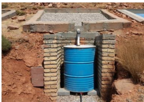
شکل (۴): نحوه اجرا و تکمیل شده سطح آبگیر پوشش نایلون با محافظ شنی
