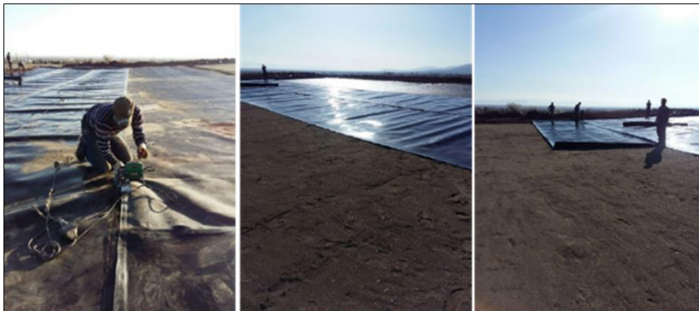
شکل (۲): عایق نمودن سطح سامانه سطوح آبخیز باران با استفاده از پوشش ژئوممبران در ایستگاه تسوج
