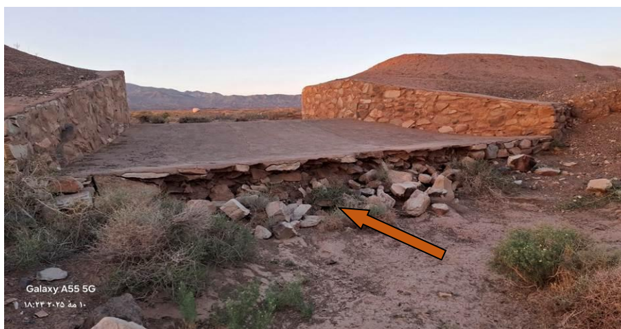
شکل ۱۱- پدیده آب‌شستگی پایین دست دروازه عبور جریان در سامانه پخش سیلاب بر آبخوان سبزوار Figure 11- Scours phenomenon downstream of the gap of the FWSS on the Sabzevar aquifer
